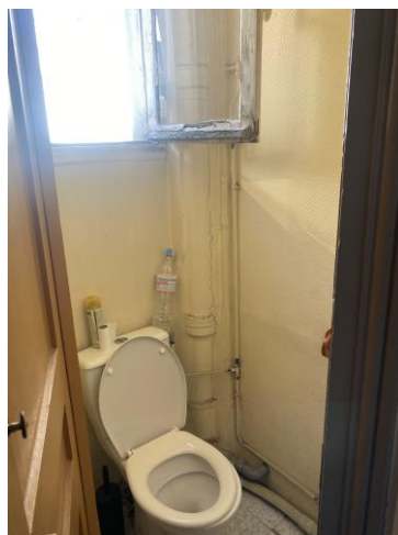
WC sur palier
